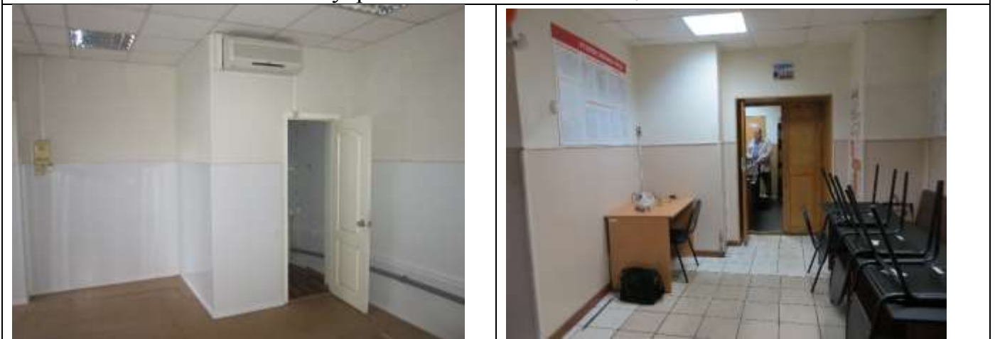
Внутреннее состояние помещений
